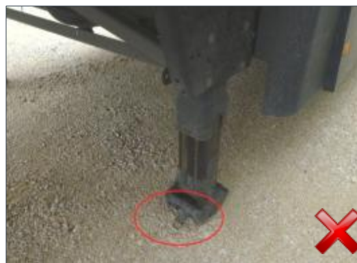
Berechnungsart: Erneuerung Teilersatz (100%)
