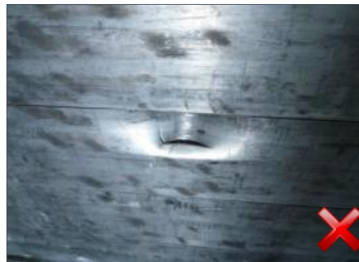
Berechnungsart: Erneuerung Teilersatz (100%)
